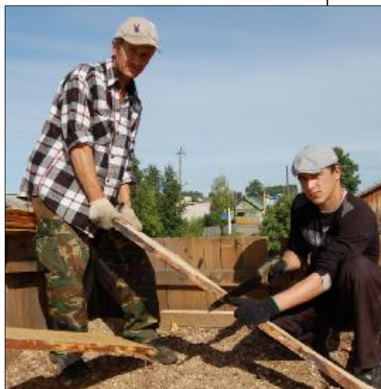
Строители Ю.А. ЗАКАПКО и И.В. ХАГАЕВ из МУП «Жилкомсервис» на обустройстве водонапорной башни по ул. Мира.
