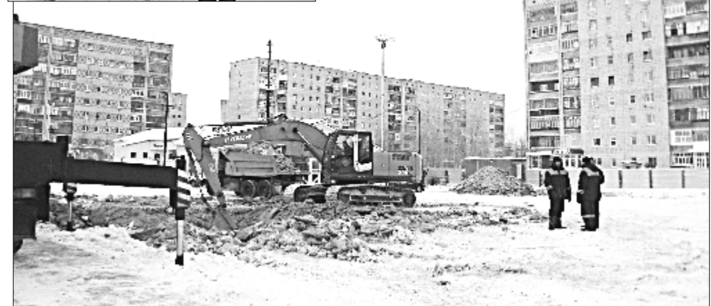
Открытие стройки крытого ледового катка. В этот день здесь была забита первая свая.
