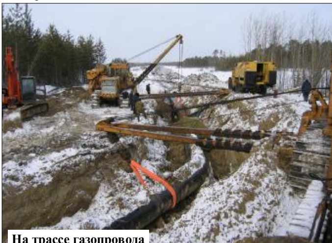
На трассе газопровода
