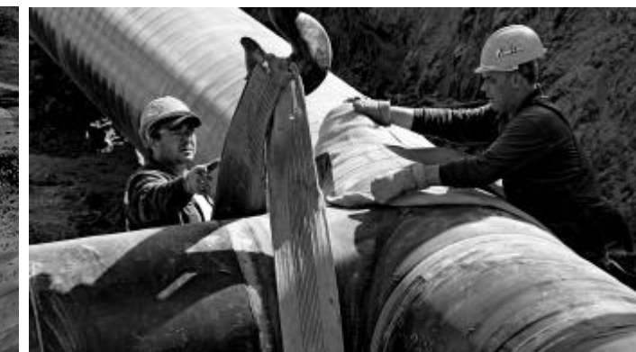
Сергей Хайрутдинов, электрогазосварщик АВП Евгений Сухотин, монтажник наружных трубопроводов АВП
