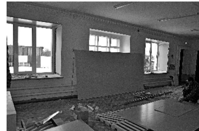
ются. Следует отметить, что двухкамерные стеклопакеты являются оптимальным вариантом остекления по шумоизоляции и теплопроводности. Суть двухкамерного стеклопакета - наличие трёх стекол, собранных двумя дистанционными рамками. У современных окон основная функция - сохранение энергоресурсов, что очень актуально для образовательных учреждений. Окна произведены в г. Сургуте, установку производит ИП С. Геворгян.
