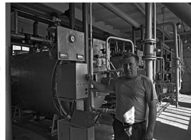
(он предназначен для резервного топлива и никогда не эксплуатировался), один – в резерве. Мощности двух котлов хватает, чтобы подавать тепло и горячую воду в обслуживаемый микрорайон. Будут произведены осмотр и чистка оборудования, частичная разборка узлов, в оснащении которых найдутся изношенные детали, замена деталей, вырабатывающих свой ресурс, устранены дефекты, выявленные в процессе эксплуатации. Котельная функционирует с 1993 года. Здесь установлены тер-
