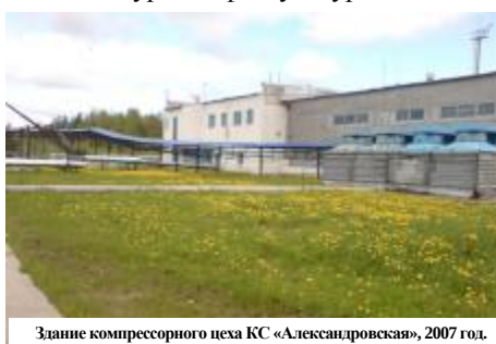
Здание компрессорного цеха КС «Александровская», 2007 год.
