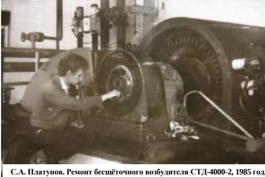
С.А. Платунов. Ремонт бесщёточного возбудителя СТД-4000-2, 1985 год.
