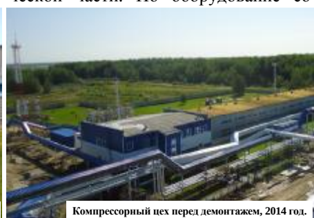
Компрессорный цех перед демонтажем, 2014 год.
