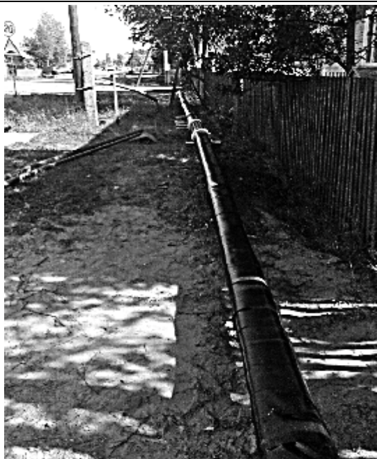
С 10 по 16 августа произведена замена ветхого участка систем тепло- и водоснабжения на улице Ленина - от дома № 29 до № 31.
